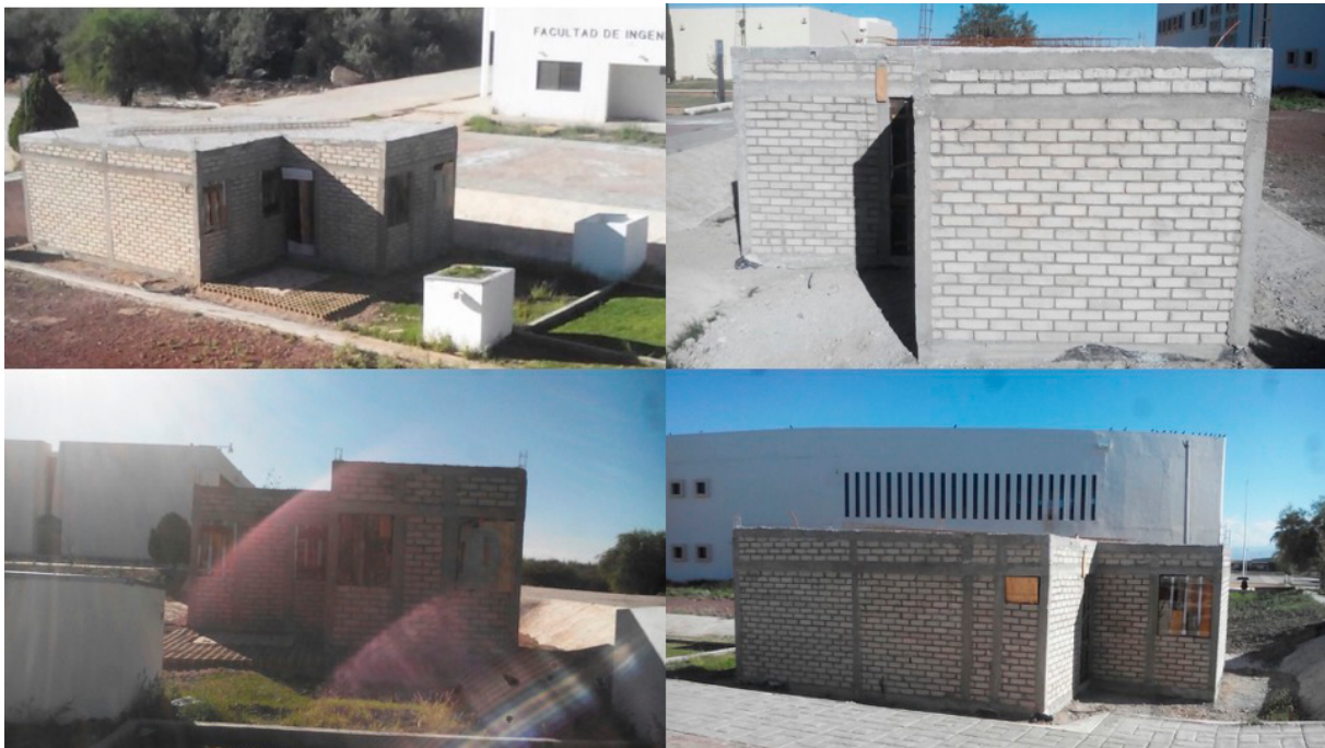
Figura 8. Fotos del Prototipo de Vivienda Edificado en Bloques de Tierra Comprimida.
