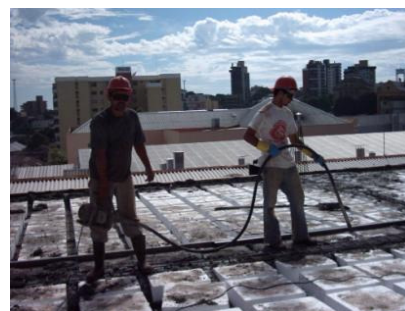
Figura 9 –Vibrados convencional
