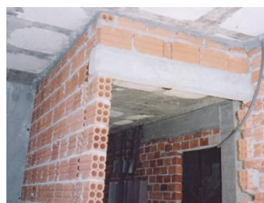
Figura 17- Verga pré moldada Fonte: Autores 2012.
