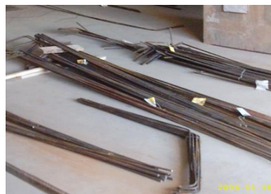
Figura 16- Aço cortado e dobrado no fornecedor Fonte: Autores 2012.
