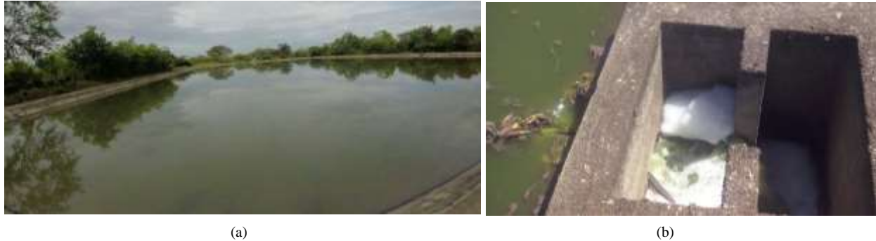
Figura 8. Presencia de algas en las lagunas primarias. (a) PTAR El Patriarca. (b) PTAR San Rafael del Sur Fuente: Propia
