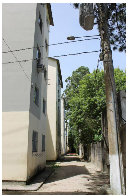
Figura 21 – Sombreamento da fachada fundos oeste do Bloco “D”
