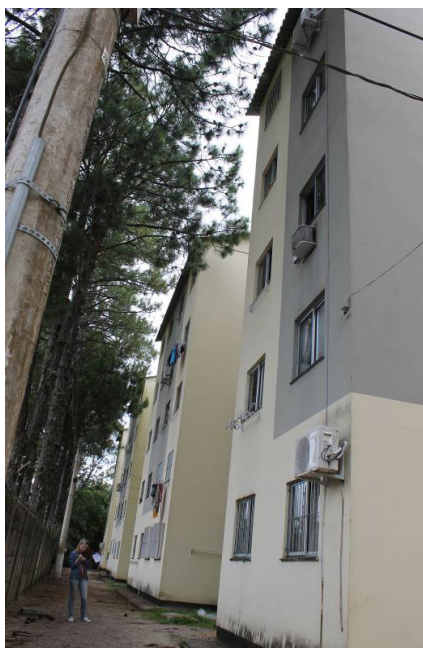
Figura 20 – Sombreamento da fachada fundos oeste do Bloco “C”
