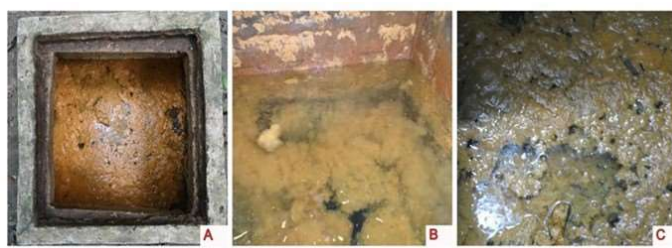
Figura 2. Se muestran diferentes ángulos donde se puede observar la biopelícula que se forma en la pila de captación (punto 1).
