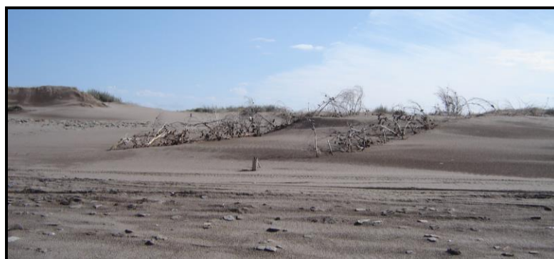
Figura 7 – Trampa de arena realizada en la zona este de Pehuen Co realizadas en el año 2005, consistió en la siembra de ramas, producto de podas del balneario, en forma perpendicular a la playa sobre el pie de médano frontal. Estas ramas hicieron las veces de trampa y acumularon a su alrededor arena generando pequeños médanos. Este proyectó se mantuvo sin ningún tipo de mantenimiento hasta fines del año 2009. Archivo personal de M. Luján Bustos (17/07/2008).
