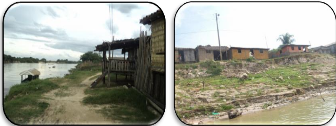
Figura 5 – Erosão e assoreamento às margens do rio Pindaré, bairro Beira Rio Fonte: Dados da Pesquisa, 2012.
