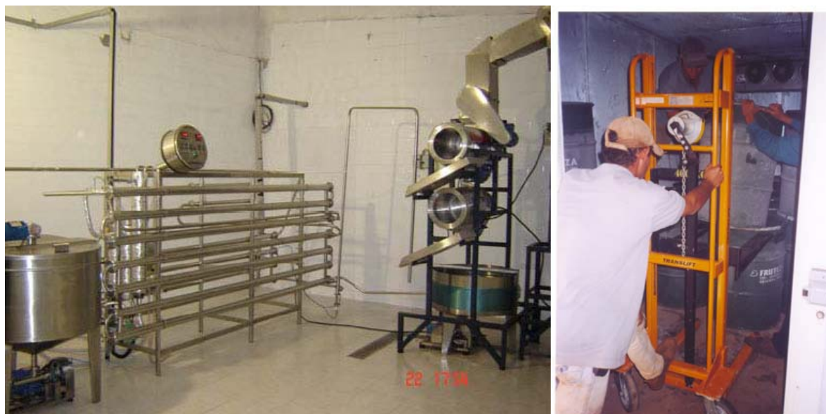
Figura 3. Vista geral do triturador, peneiras, pasteurizador e empilhadeira, Bauru (SP).
