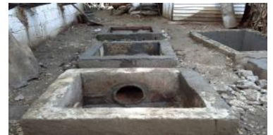
Figura 6: Construcción del sistema.
