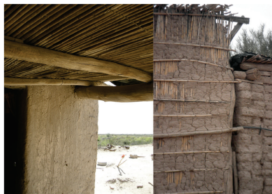
Figura 4. A la izquierda, cubierta construida con rollizo de álamo, caña como malla de repartición, torta de barro y lámina de polietileno. A la derecha, muro de quincha combinado con muro de adobe.
