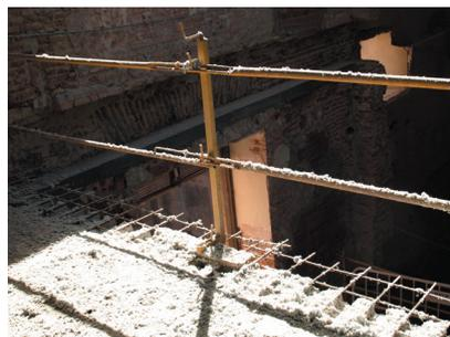
Fotografía 1. Sistema provisional de protección de borde clase A colocado habitualmente en obra.
