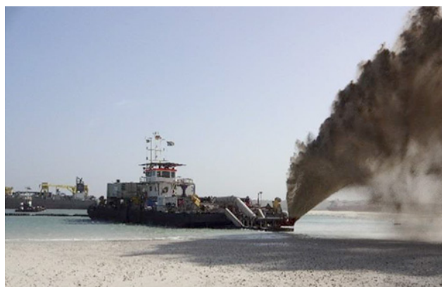
図7 浚渫船からの埋立砂の排出
