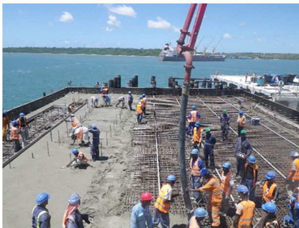
図10 棧橋上でのコンクリート床板築造の様子
