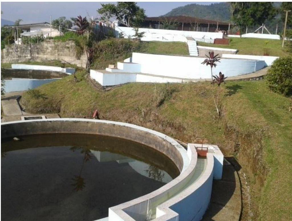
Imagen No. 3. Infraestructura del Acueducto.
