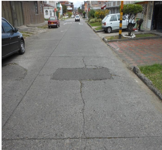
Figura 24. Parche asfáltico
