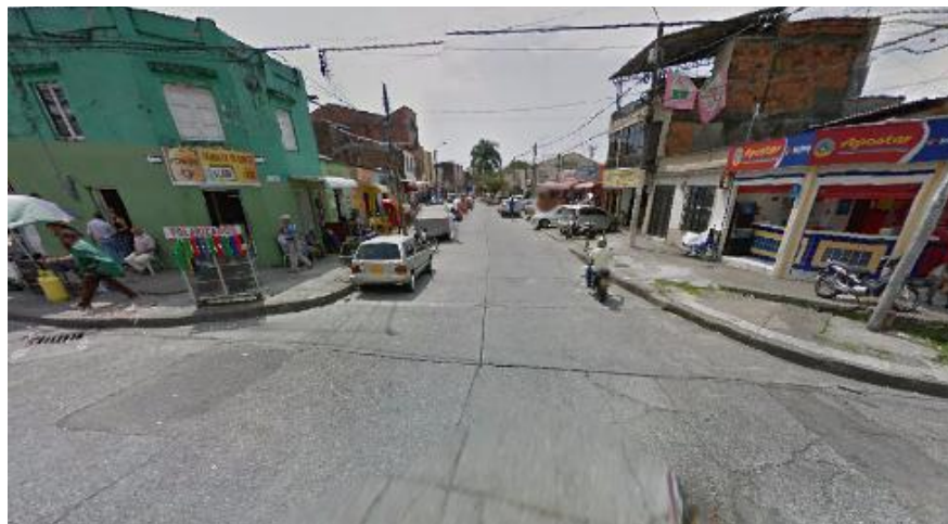
Figura 32. Andenes sin rampas.
