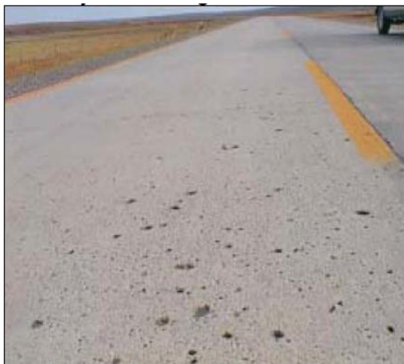
Figura 8. Deterioro superficial.
