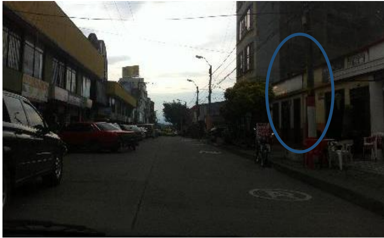
Figura 35. Ubicación de los postes de alumbrado público.
