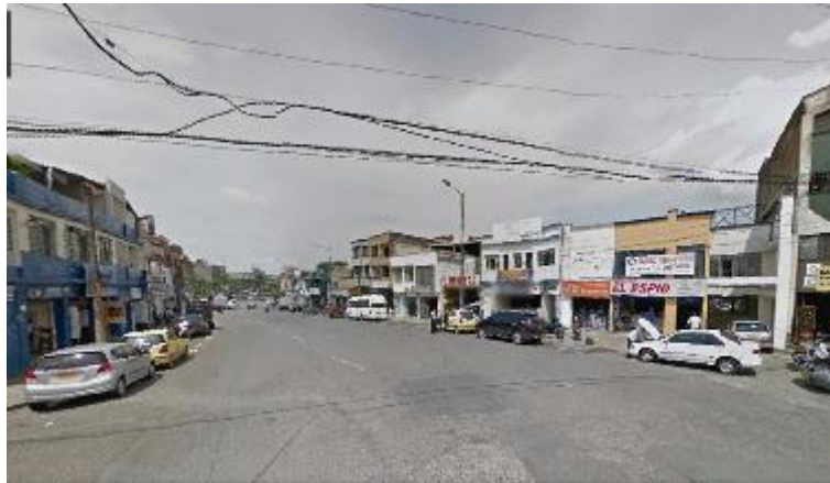
Figura 31. Daños Pavimento Flexible Carrera 12.
