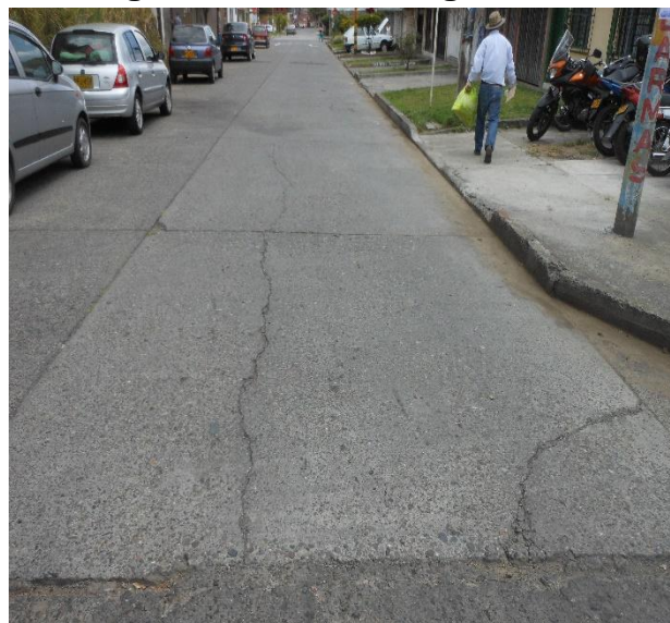
Figura 22. Grieta longitudinal.
