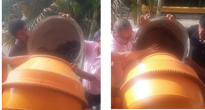
Figura 56. Adición agregado grueso y agregado fino.
