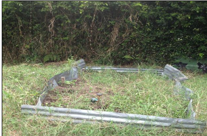
Figura 13. Cerramientos de talud con zinc de 2 m x 3 m, Combia (Pereira) Fuente: tomada en campo.
