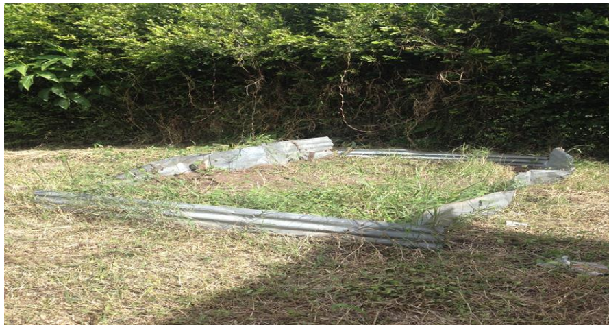
Figura 21. Construcción terminada del predio de escorrentía ubicado en Combia (Pereira)
