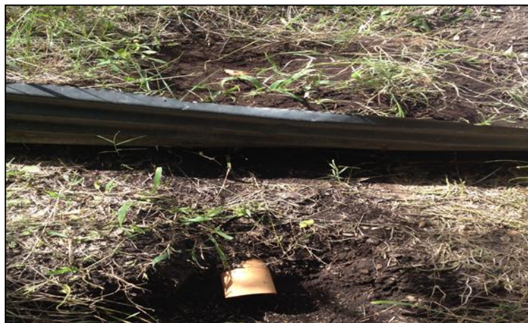
Figura 16. Talud Combia (Pereira). Vista en planta de la tubería Fuente: Trabajo de campo
