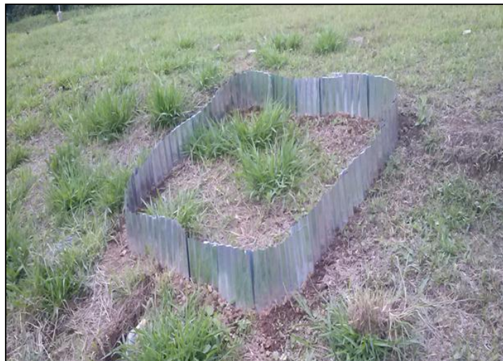
Figura 12. Cerramientos de talud con zinc de 2 m x 2 m, Milán (Dosquebradas). Fuente: tomada en campo
