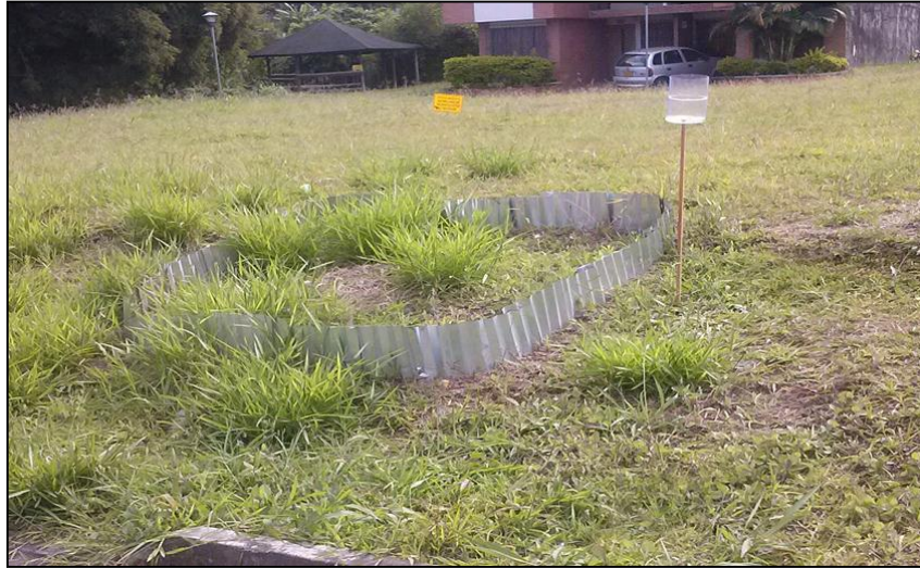
Figura 20. Construcción terminada del predio de escorrentía ubicado en Milán (Dosquebradas).
