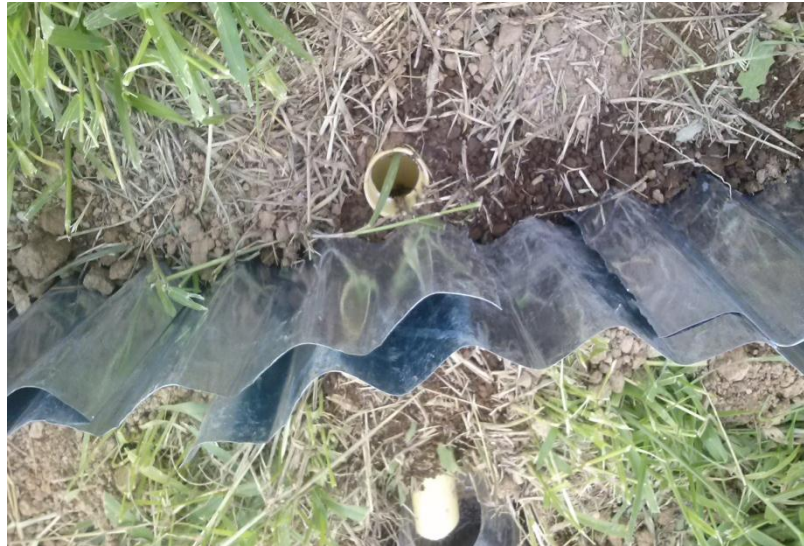
Figura 15. Talud Milan (Dosquebradas). Vista en planta de la tubería Fuente: Trabajo de campo
