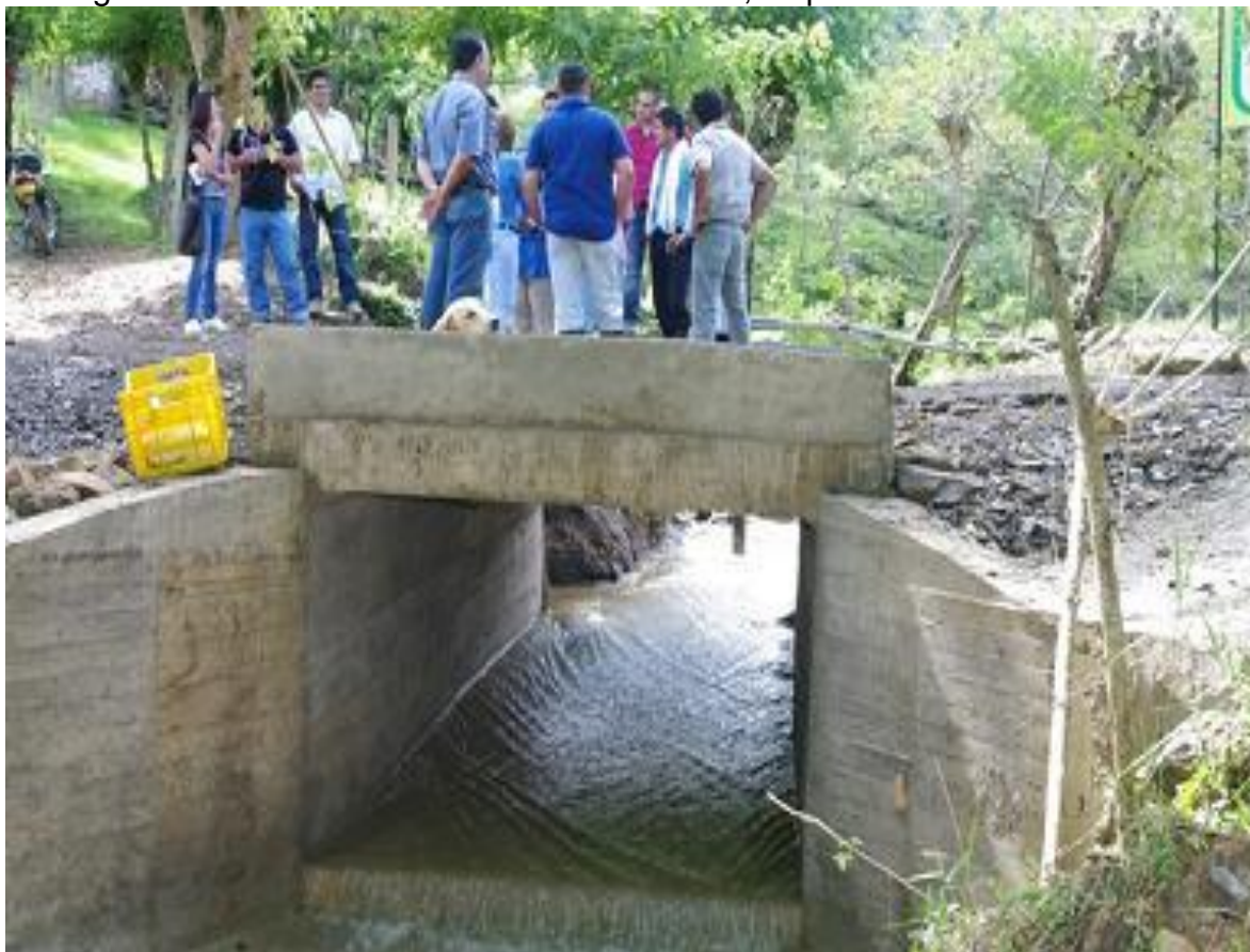
Figura 9. Box Culvert en la vereda de Mérida, Departamento de Santander.
