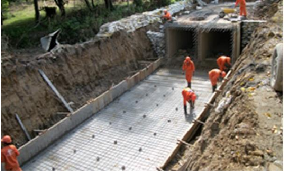
Figura 10. Construcción box Culvert en ciudad de Villavicencio
