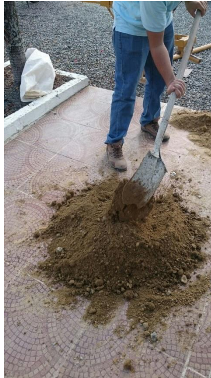
Figura 12. Mezcla de suelo, cemento, escombros y agua
