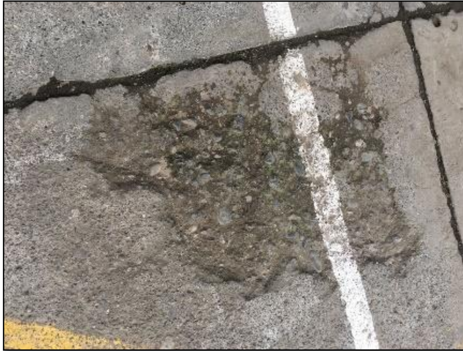
Imagen 22 Placa de concreto en cancha
