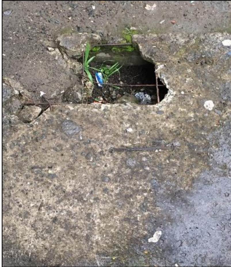
Imagen 23 Placa de concreto
