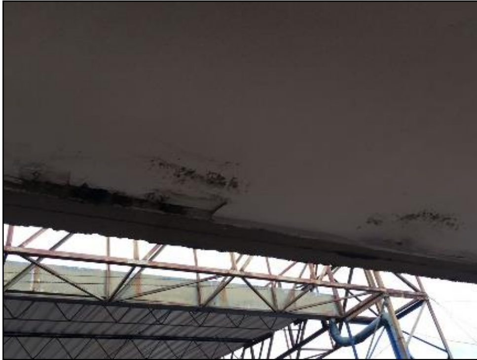
Imagen 26. Placa de Cubierta
