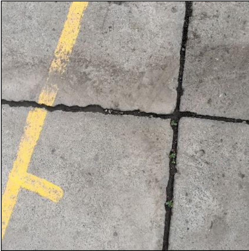
Imagen 21 Placa de concreto cancha.
