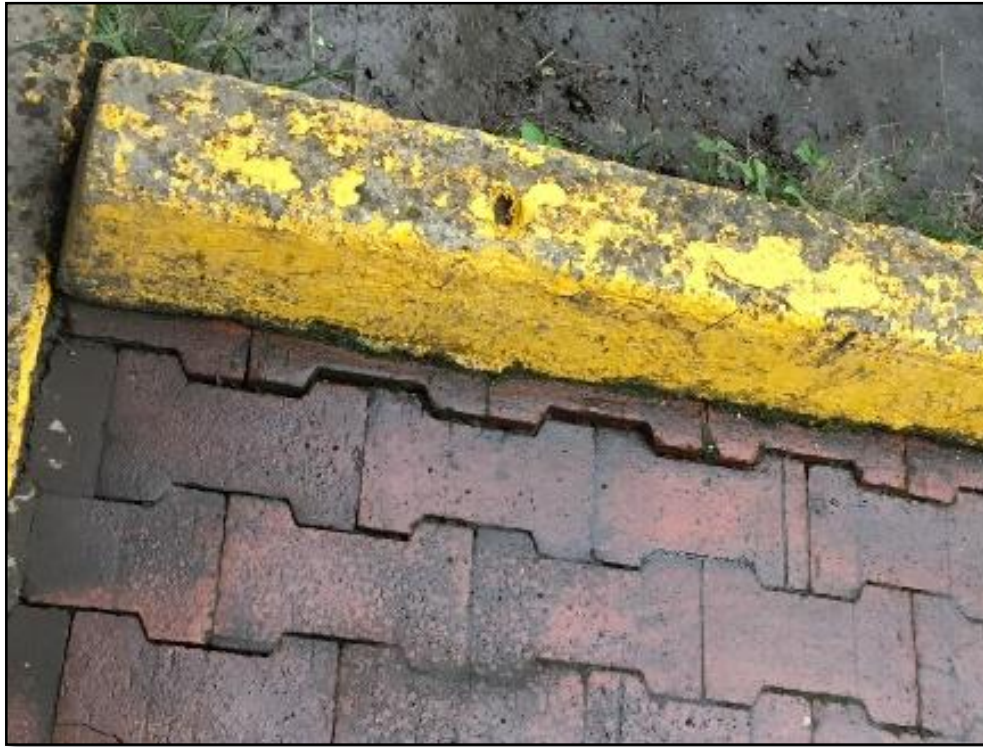
Imagen 29 Pavimento articulado, en adoquín.
