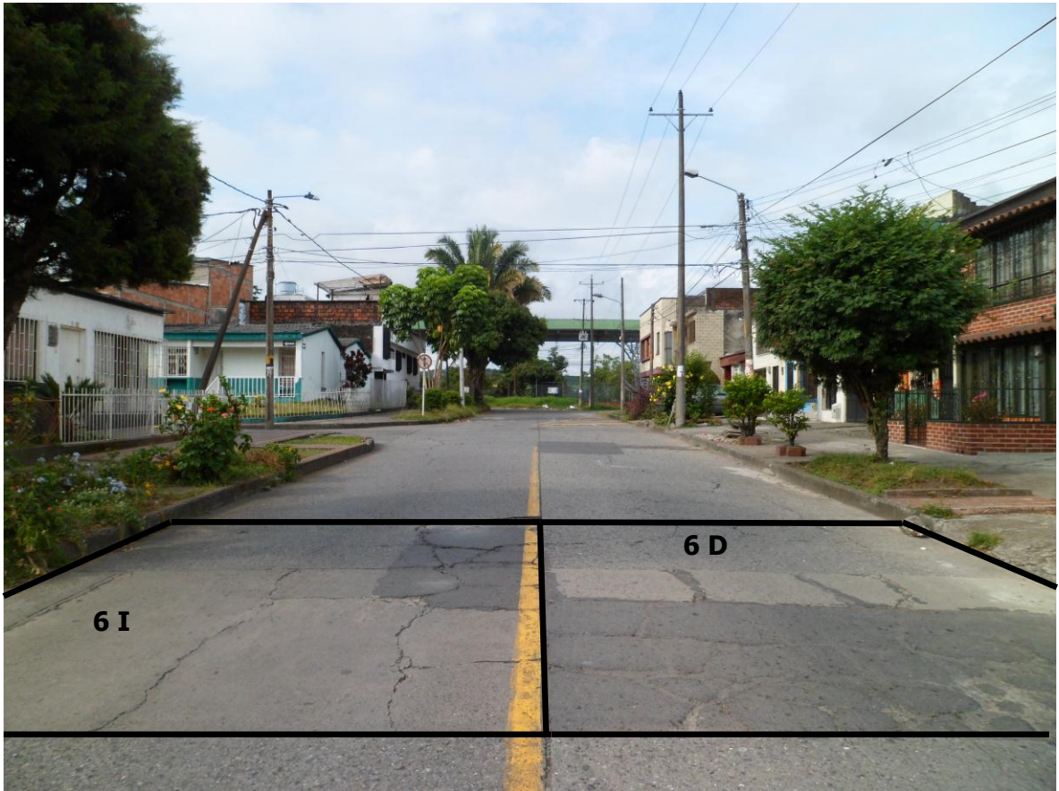
Foto 7. Tramo vehicular C 2 (Cl 24 entre Cra 19 y Cra 19 Bis) pavimento rígido.
