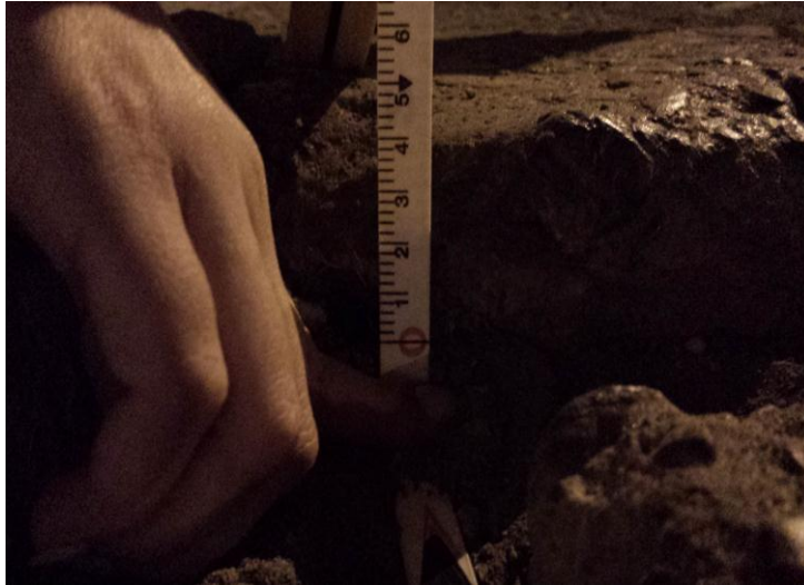
Foto 11. Estructural existente del pavimento flexible.
