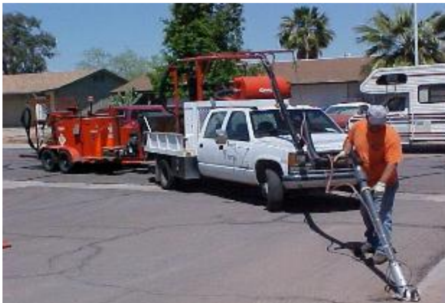
Foto 1. Sello de fisuras y grietas.
