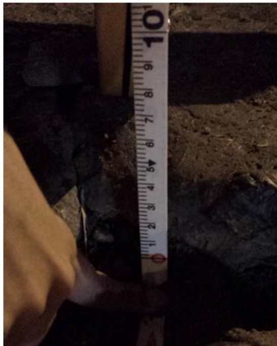
Foto 10. Estructura existente del pavimento rígido.
