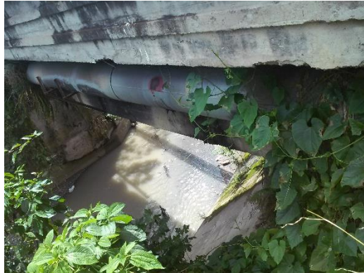
FIGURA 55: Estribos y apoyos de la estructura existente
