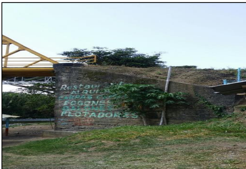
Figura 11. Talud de soporte del puente.
