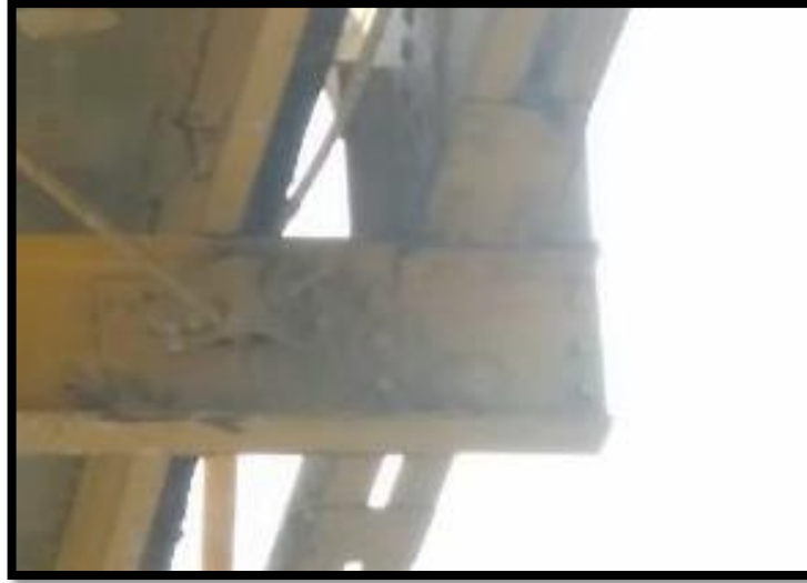
Figura 15. Levantamiento de uniones en viga.
