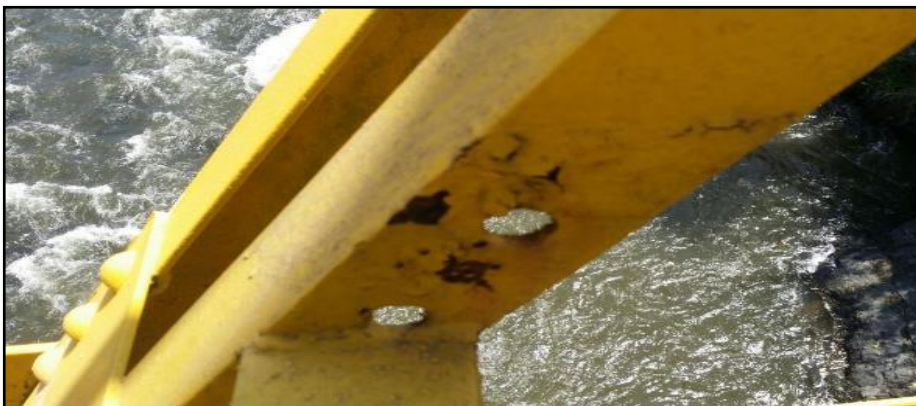
Figura 10. Vista lateral de una vigueta.
