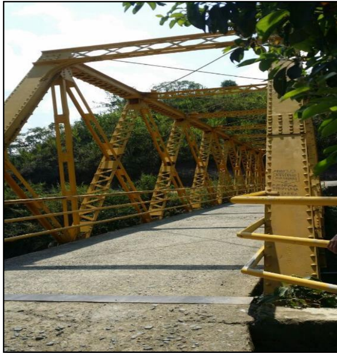
Figura 9. Vista frontal del puente.
