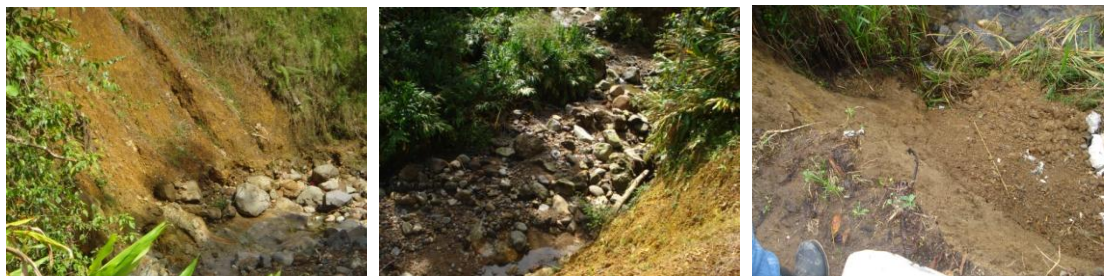
Figuras 82, 83 y 84. Desprendimientos activos
