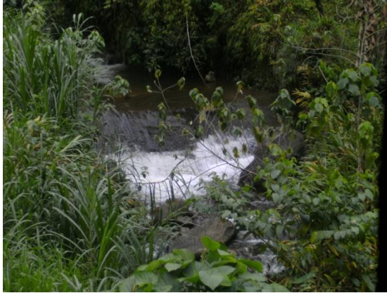
Figura 101. Disipador inclinado a 45°
