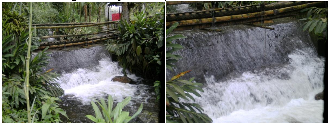
Figuras 99 y 100. Disipadores inclinado a 45°
