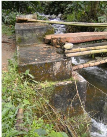
Figura 96. Muro de contención en concreto
