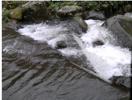
Figura 105. Disipador inclinado a 45°
