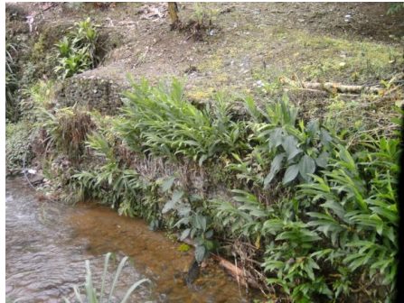
Figura 92. Muro en gavionería
