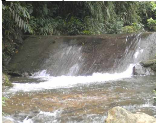
Figura 106. Disipador inclinado a 45°
