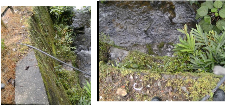
Figuras 93 y 94. Muro de contención en concreto
