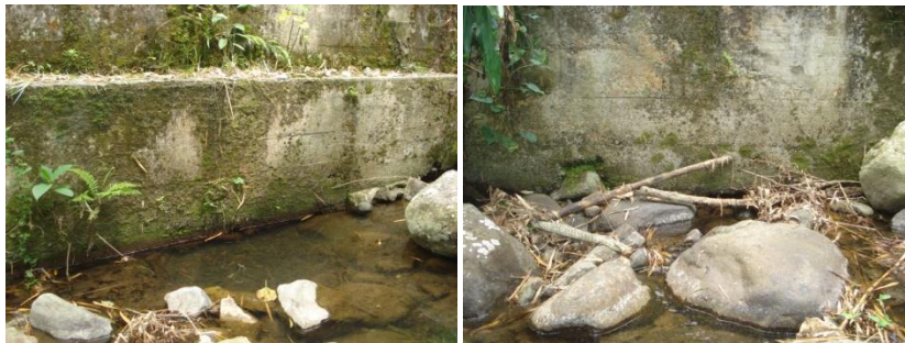
Figuras 110 y 111. Patas de gaviones revestidos
