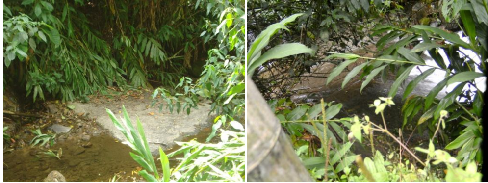
Figuras 103 Y 104. Disipador inclinado a 45°
