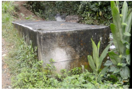
Figura 95. Muro de contención en concreto
