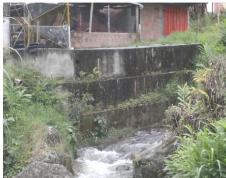
Figura 91. Muros de contención en concreto
