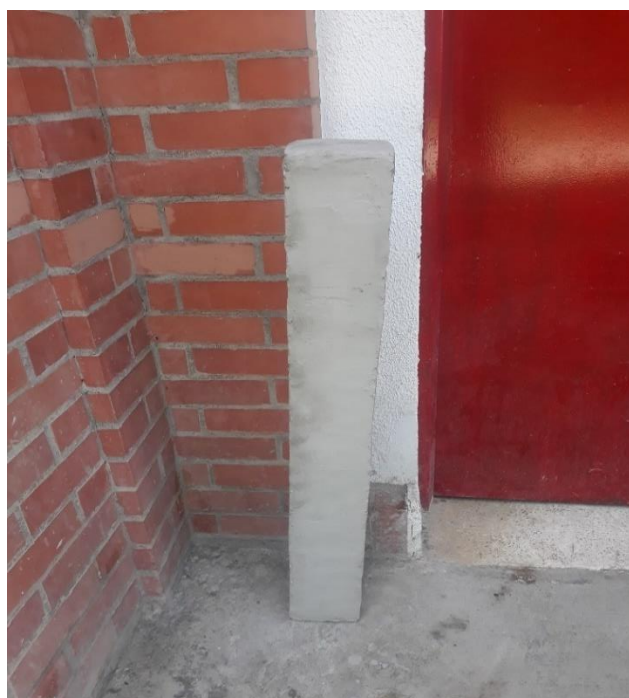
Figura 68. Columna construida. Fuente: Elaboración propia.
