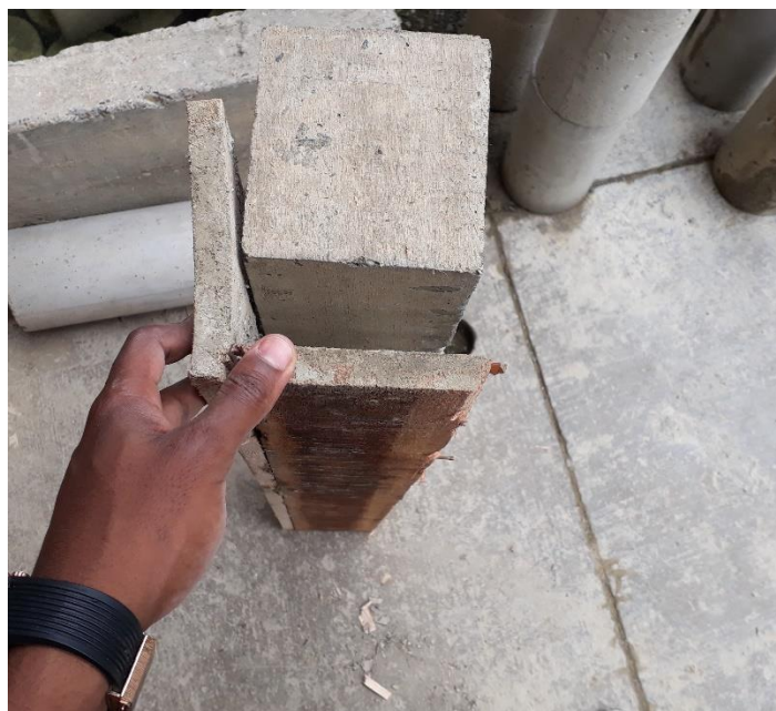
Figura 67. Desencofre de la columna. Fuente: Elaboración propia.
