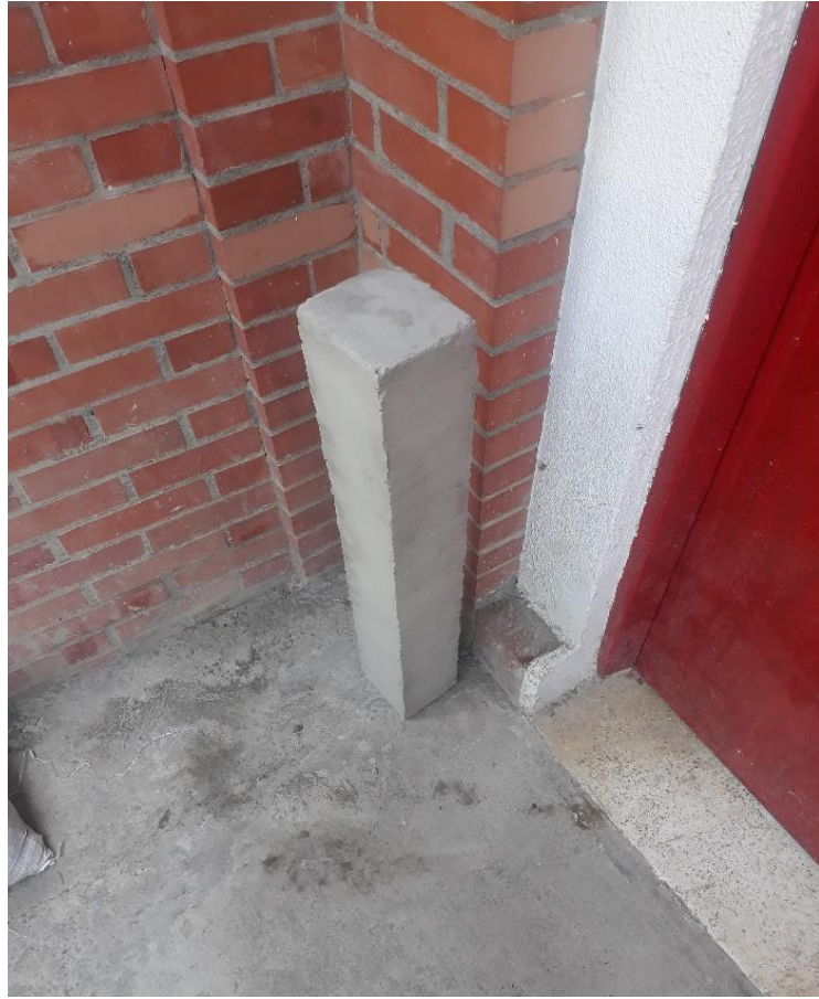
Figura 69. Columna construida. Fuente: Elaboración propia.
