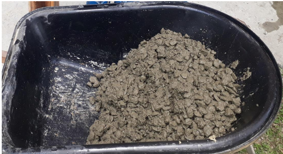
Figura 61. Mezcla para el vaciado de la columna. Fuente: Elaboración propia.
