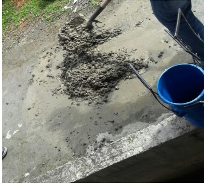
Figura 57. Mezcla para vaciado de cilindros. Fuente: Elaboración propia.
