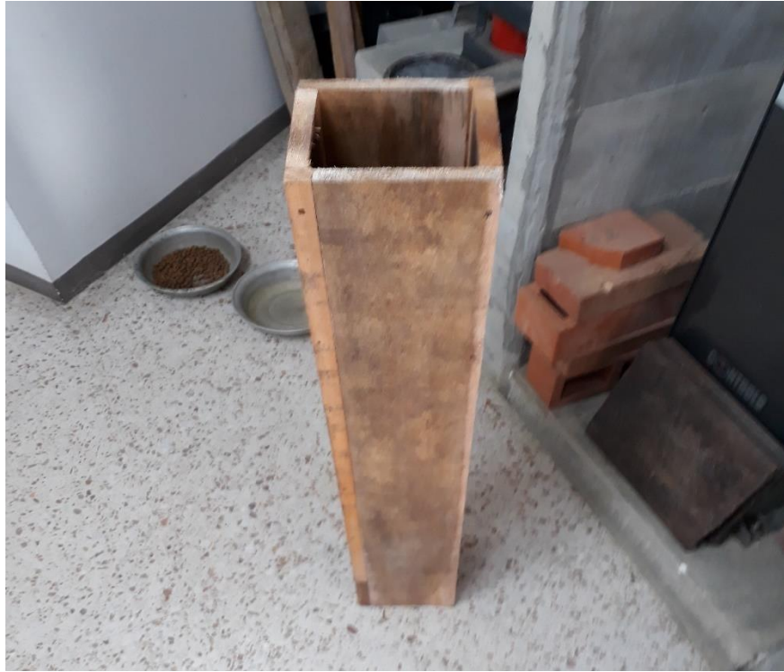
Figura 37. Formaleta para vaciar el concreto. Fuente: Elaboración propia.
