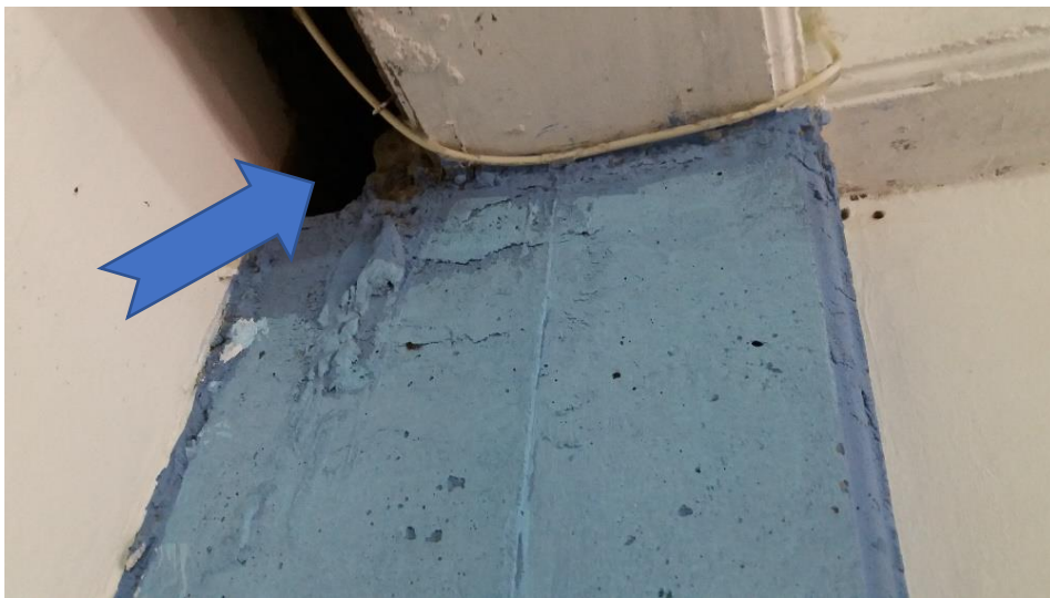
Figura 16. Columna y vigas Fuente Propia
