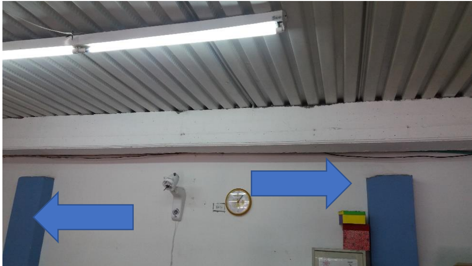
Figura 15. Columnas Fuente Propia
