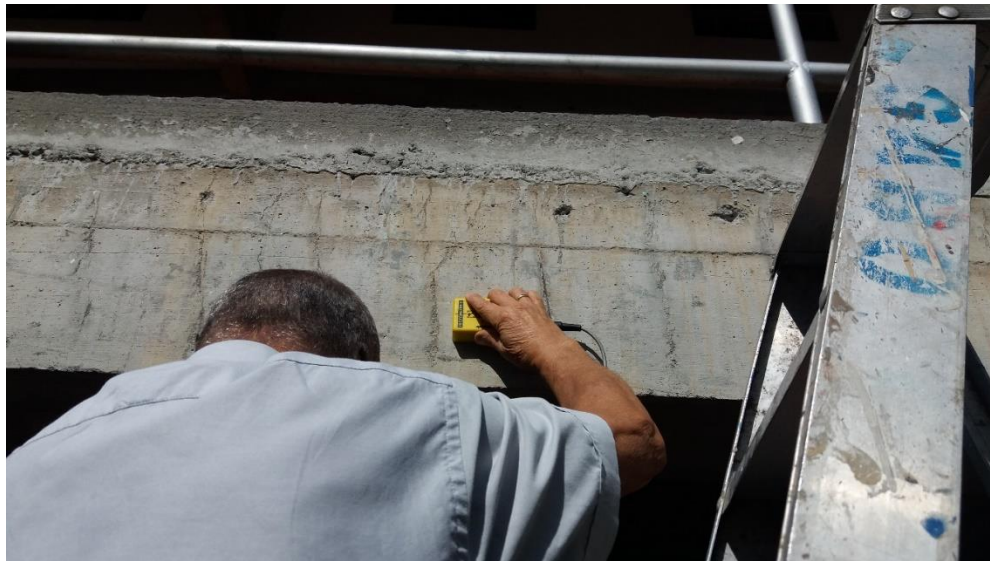
Figura 28. Prueba en viga con ferroscaan Fuente Propia
