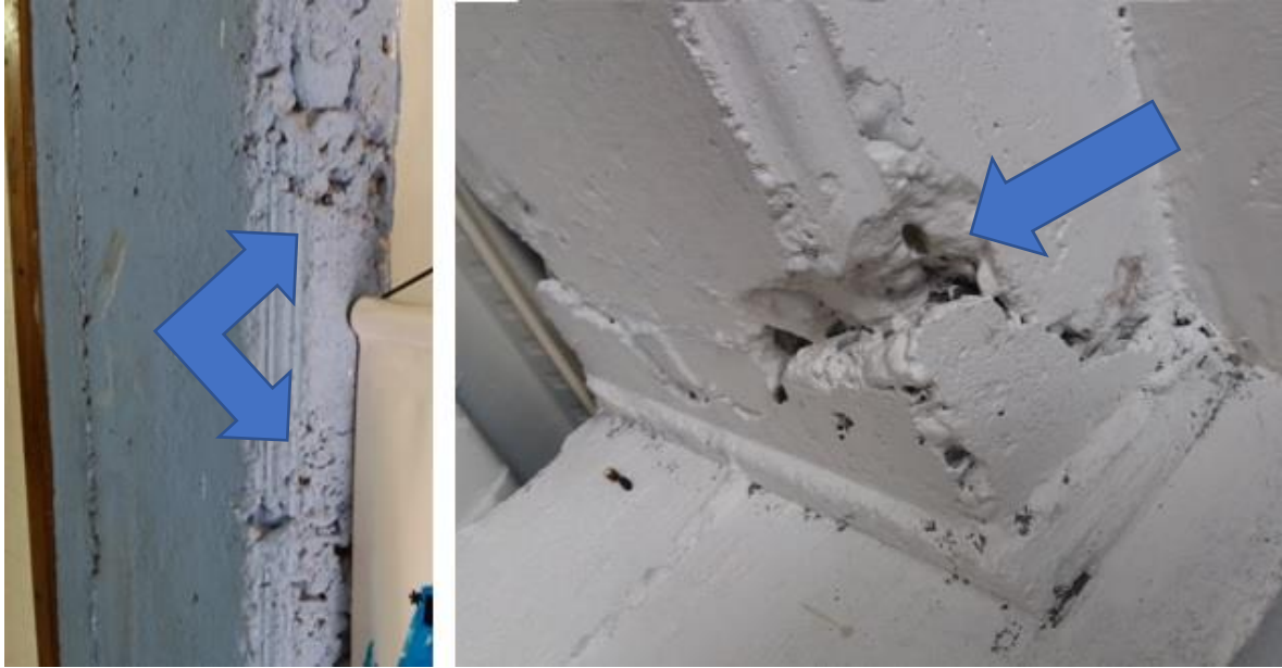
Figura 17. Columna y vigas hormigueadas Fuente Propia
