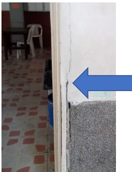
Figura 14. Vano de puerta Fuente Propia
