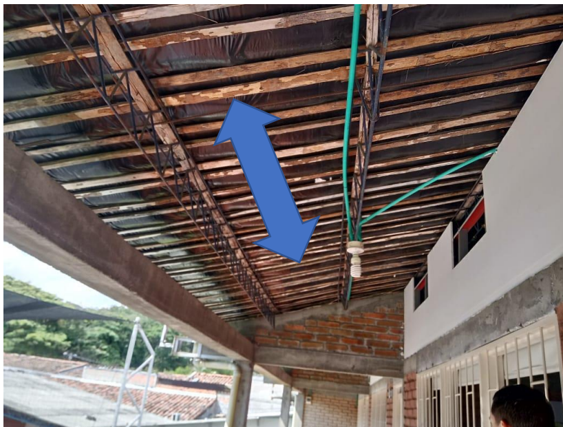
Figura 20. Cubierta 2 piso Fuente Propia
