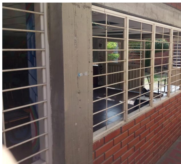
Figura 18. Columna corta Fuente Propia
