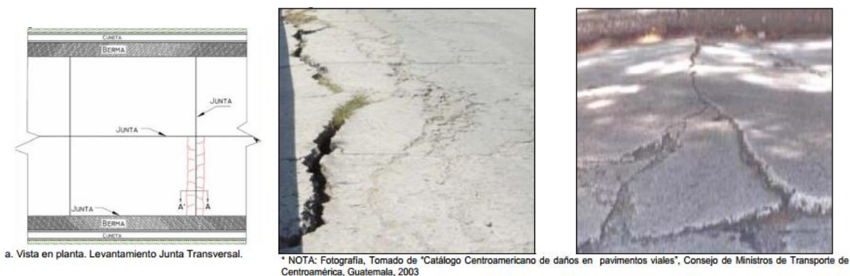
Ilustración 26. Levantamiento localizado Fuente: Manual de inspección de INVIAS
