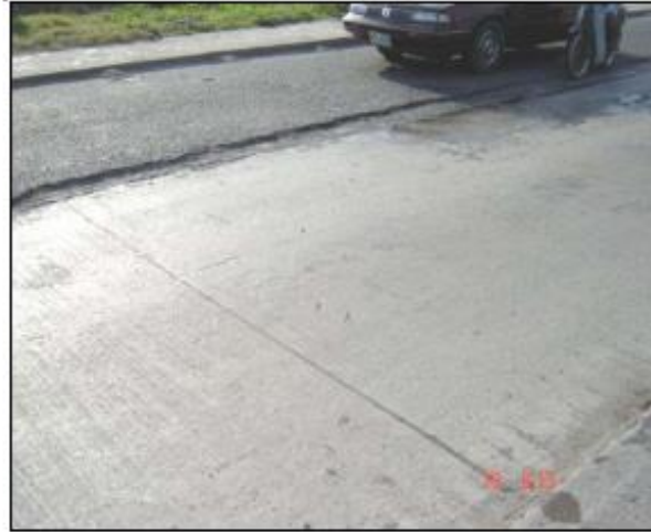
Ilustración 24. Pulimento Fuente: Manual de inspección de INVIAS
