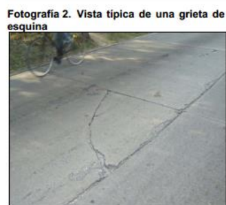
Ilustración 12. Grieta de esquina Fuente: Manual de inspección de INVIAS
