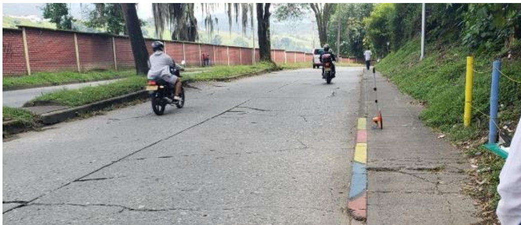
Figura 8. Levantamiento de placas (Fuente: Los Autores de la investigación)
