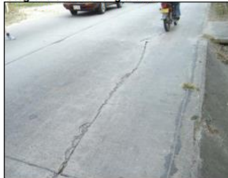
Ilustración 13. Grieta longitudinal Fuente: Manual de inspección de INVIAS
