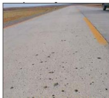
Ilustración 22. Desintegración
