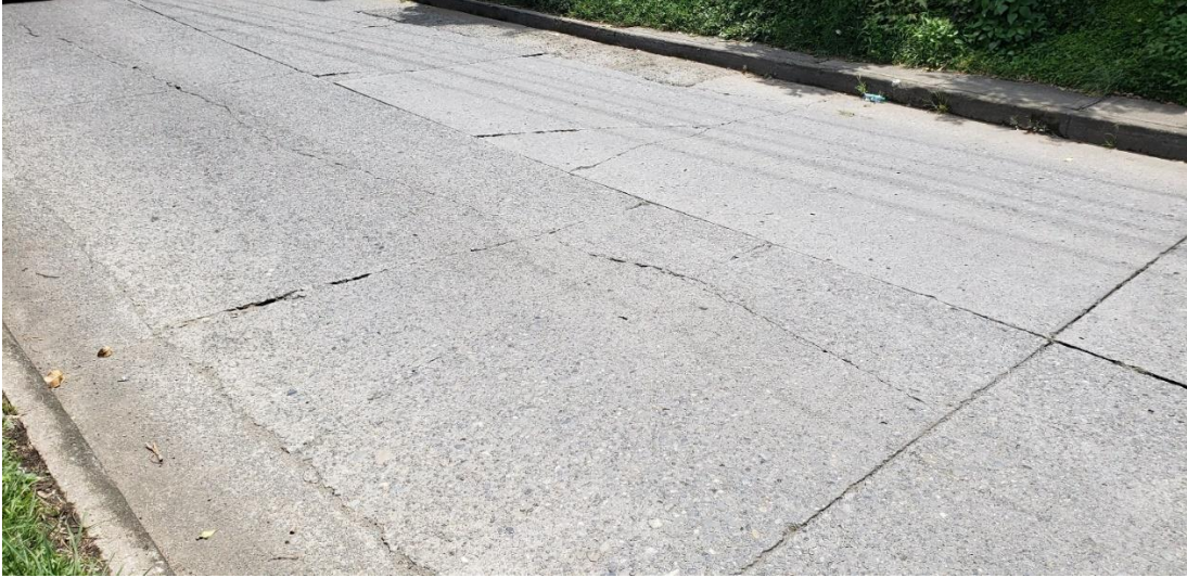
Figura 10. Longitudinales y transversales (Fuente: Los Autores de la investigación)
