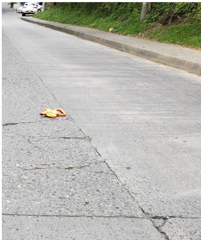
Figura 4. Pulimiento, severidad media (Fuente: Los Autores de la investigación)
