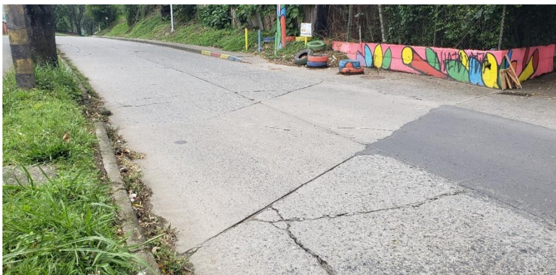
Figura 17. Inicio andén peatonal (Fuente: Los Autores de la investigación)
