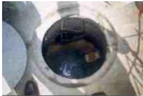
FOTO N°4. Cámara alcantarillado de Dosquebradas.
