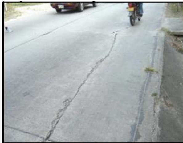
Fotografía 3. Grieta Longitudinal
