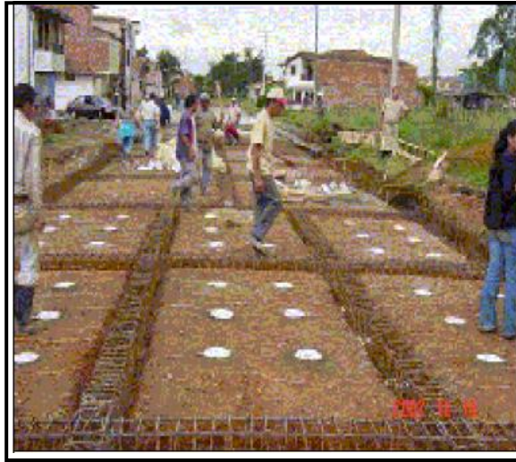
Fotografía 1. Vista típica del proceso constructivo de losas continuamente reforzadas
