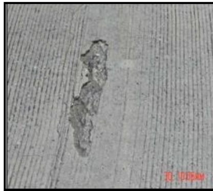
Fotografía 7. Vista típica de un descascaramiento
