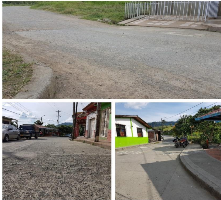
Imagen 11. Registro fotográfico de pavimentos Corregimiento de La Florida.
