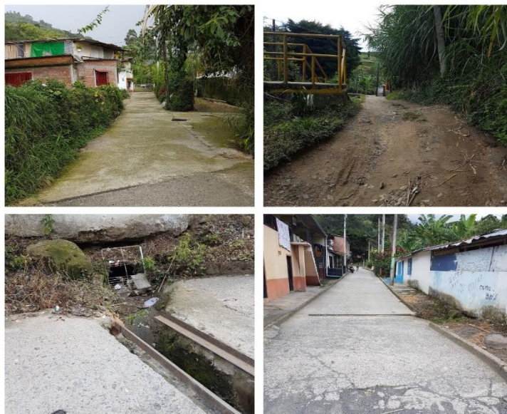
Imagen 12. . Registro fotográfico de pavimentos Vereda Gaitán Bajo.
