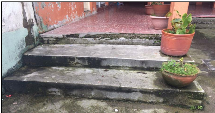
Imagen 15. Escaleras de acceso a los baños en la institución Antonia Santos.
