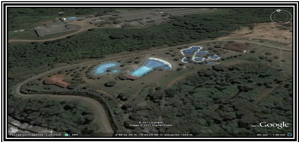
Figura 11. Fotografía aérea de la antigua vía de acceso al parque metropolitano del café.
