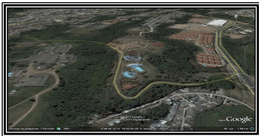
Figura 12. Fotografía aérea del proyecto de la calle 50.
