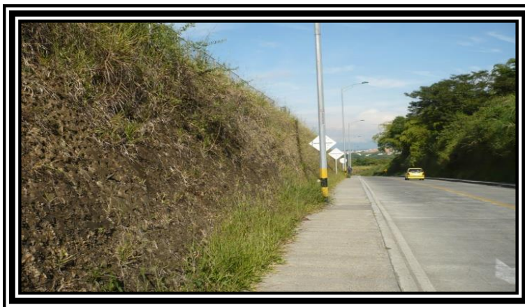
Figura 6. Talud De Estudio Forma De La Pendiente
