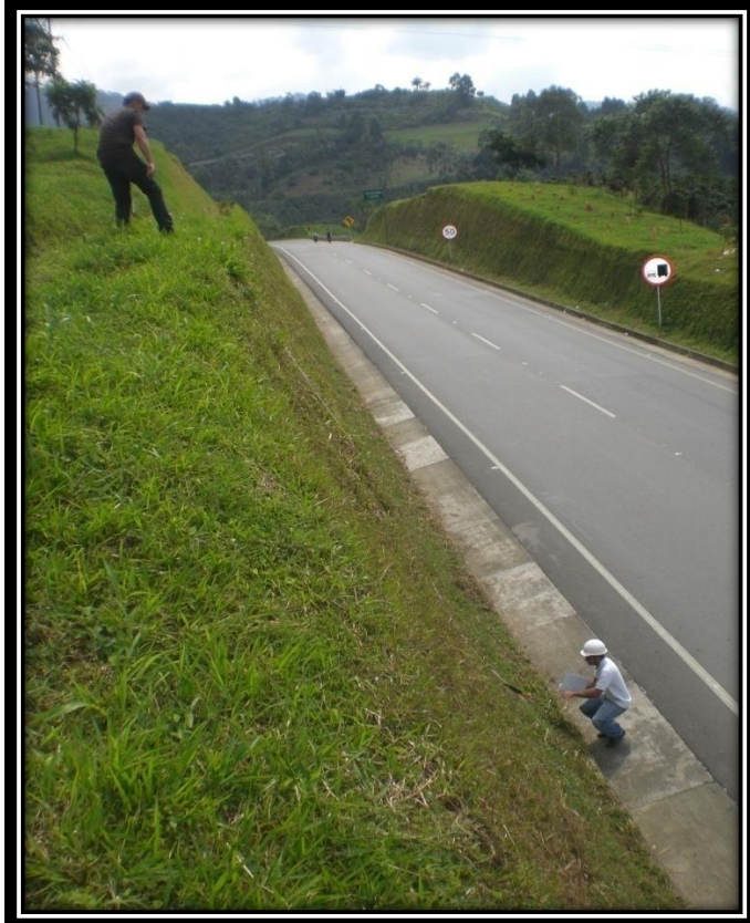
Vía I29 Norte Puente Helicoidal. Talud Inicio doble calzada La Romelia-Santa Rosa
