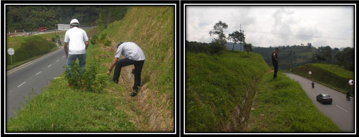
Figura 8. Foto del Talud de Estudio Inicio doble calzada La Romelia-Santa Rosa. Vía I29 Norte Puente Helicoidal.
