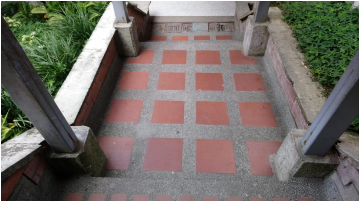
Figura 23: Deterioro estructura metálica
