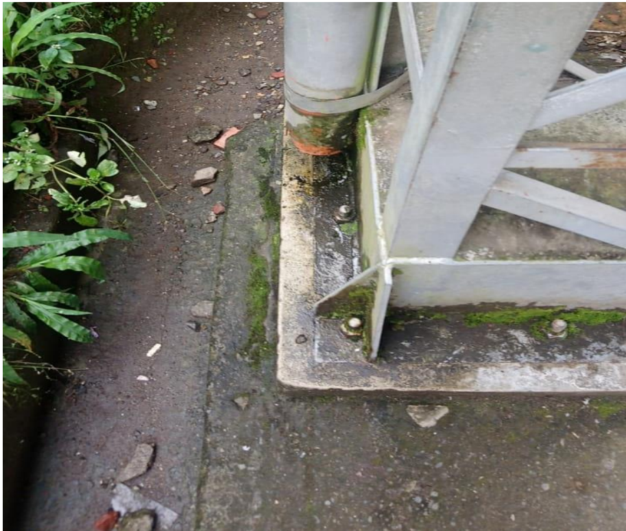
Figura 24: Bajante de aguas lluvias.
