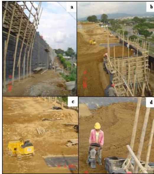
Figura 22: Procedimiento constructivo de muros, en tierra reforzada-suelos derivados de cenizas volcánicas. (Pereira, Colombia). Fuente: Herrera, 2006.
