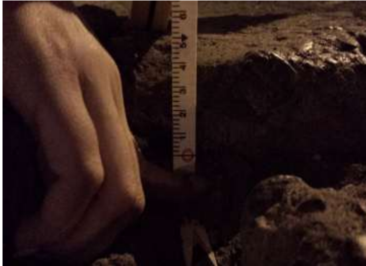
Foto 11. Estructural existente del pavimento flexible.
