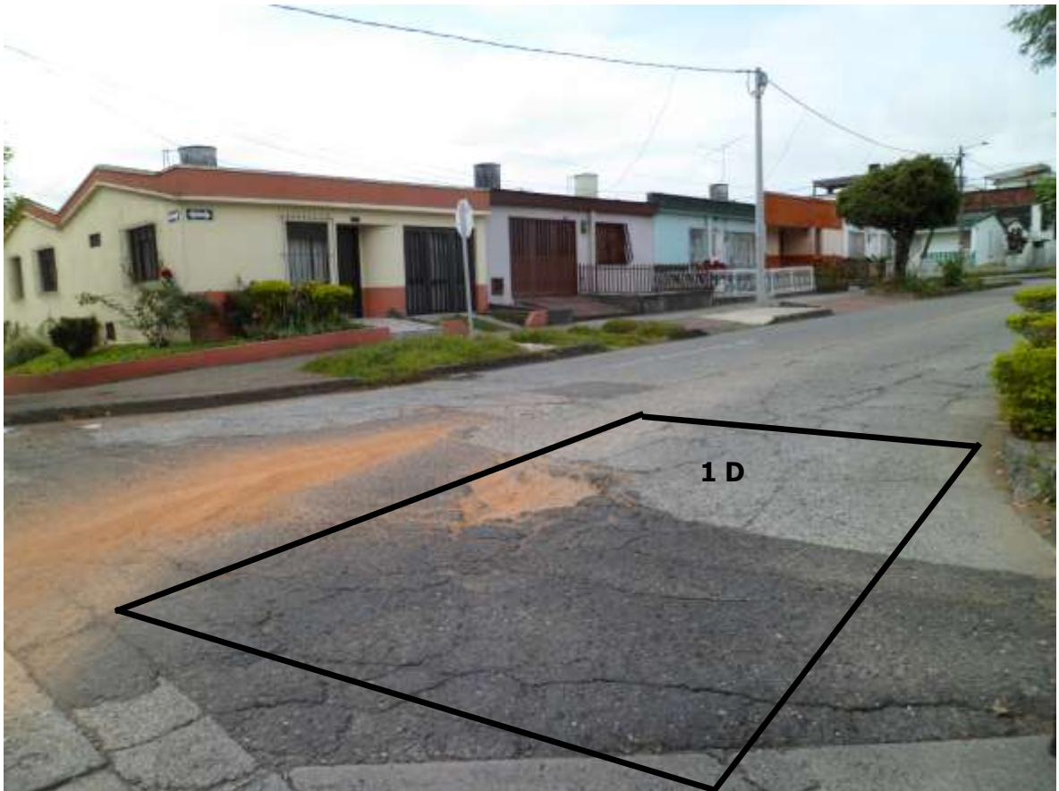
Foto 6. Tramo vehicular C 2 (Cl 24 entre Cra 19 y Cra 19 Bis) pavimento rígido.
