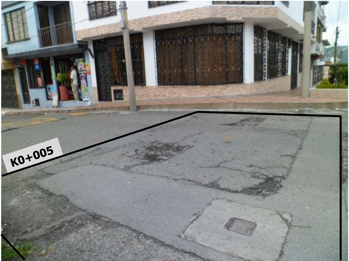
Foto 5. Tramo vehicular K 15 (Cra 20 entre Cl 23 y Cl 22 Bis) pavimento flexible del K0+005 al K0+008.
