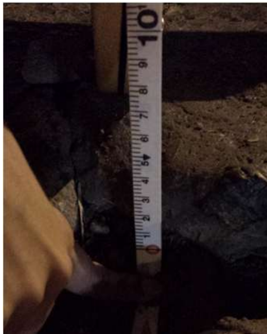
Foto 10. Estructura existente del pavimento rígido.
