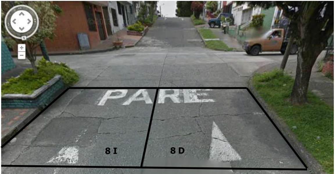
Foto 9. Tramo vehicular C 5 (Cl 23 entre Cra 19 y Cra 19 Bis) pavimento rígido.
