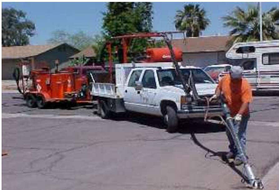
Foto 1. Sello de fisuras y grietas.
