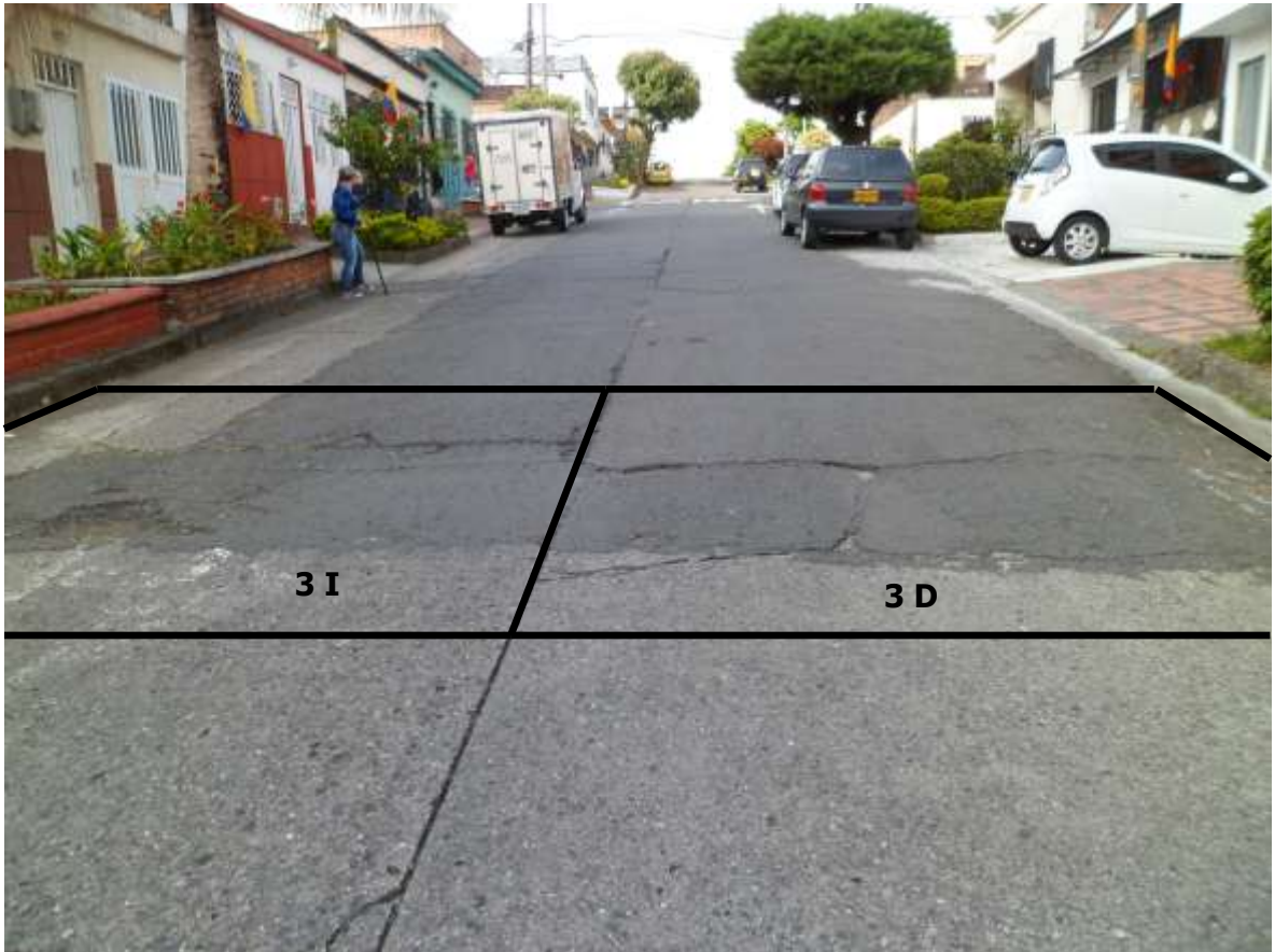
Foto 8. Tramo vehicular C 5 (Cl 23 entre Cra 19 y Cra 19 Bis) pavimento rígido.
