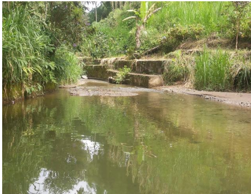
Figura 11: Bocatoma aguas arriba. Dosquebradas, 2014.
