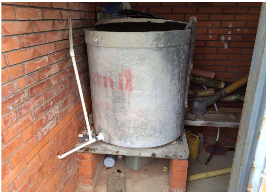
Figura 19: Tanque donde se almacena el cloro, Dosquebradas, 2014.
