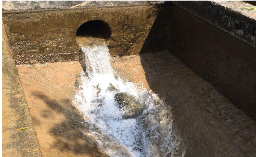
Figura 15: Entrada línea de aducción a desarenador, Dosquebradas, 2014
