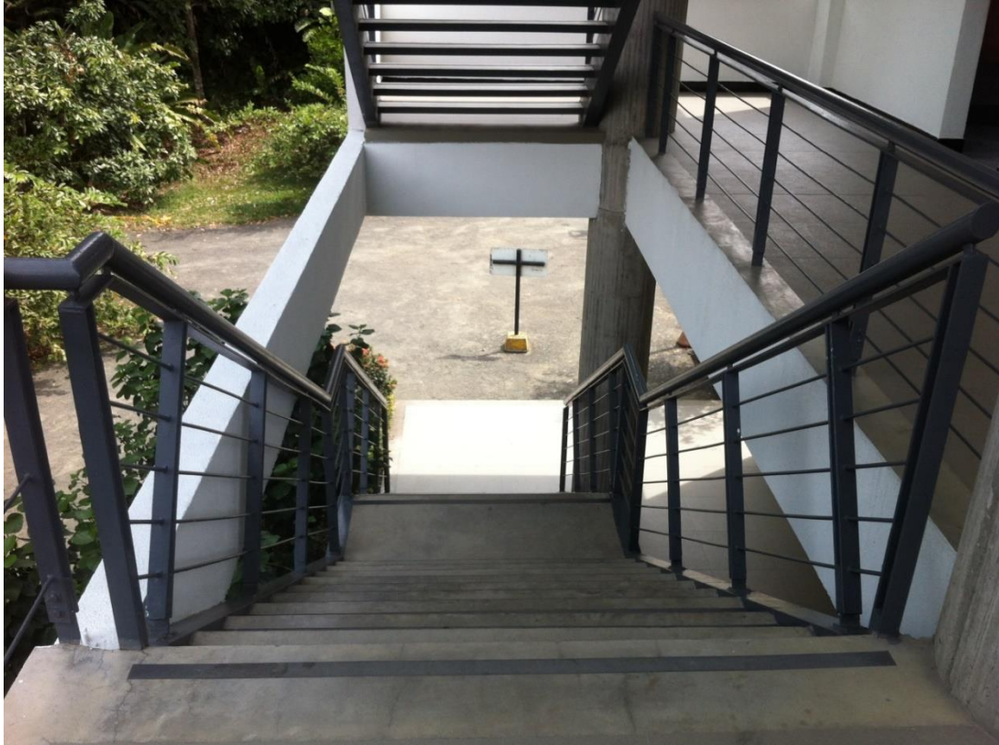
Figura 18: Escaleras de acceso al bloque del Edificio de Posgrados
