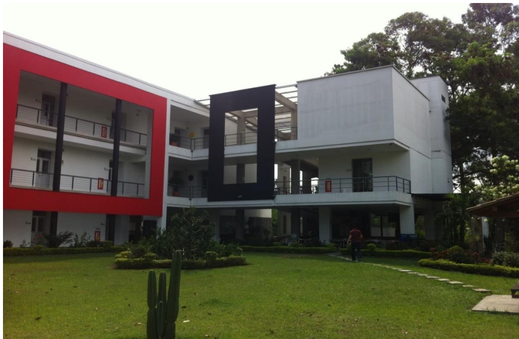
Figura 9: Bloque nuevo Edificio de Posgrados
