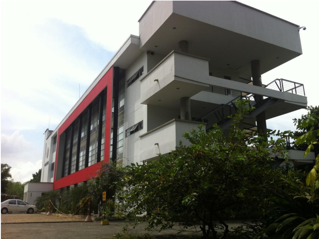
Figura 17: Bloque nuevo Edificio de Posgrados
