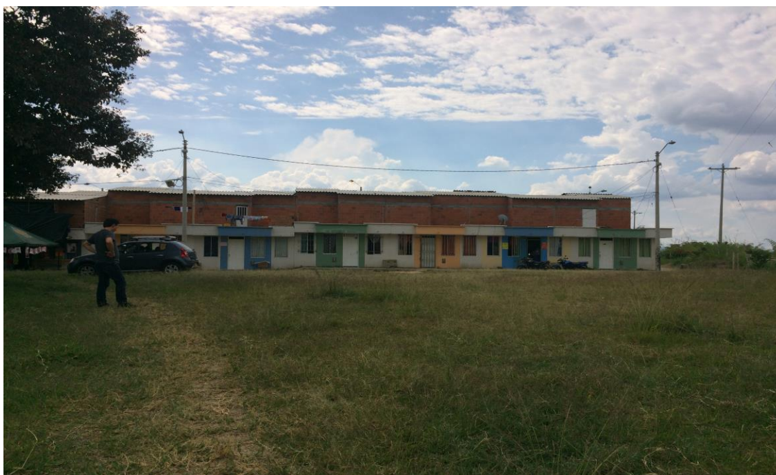
Este espacio al descubierto es la única zona verde o de recreación para los niños y residentes de Jardín de la Fachada.
