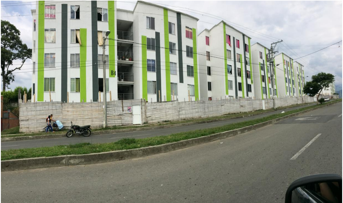
Cerramiento en esterilla construido por la comunidad en Villa Esperanza.
