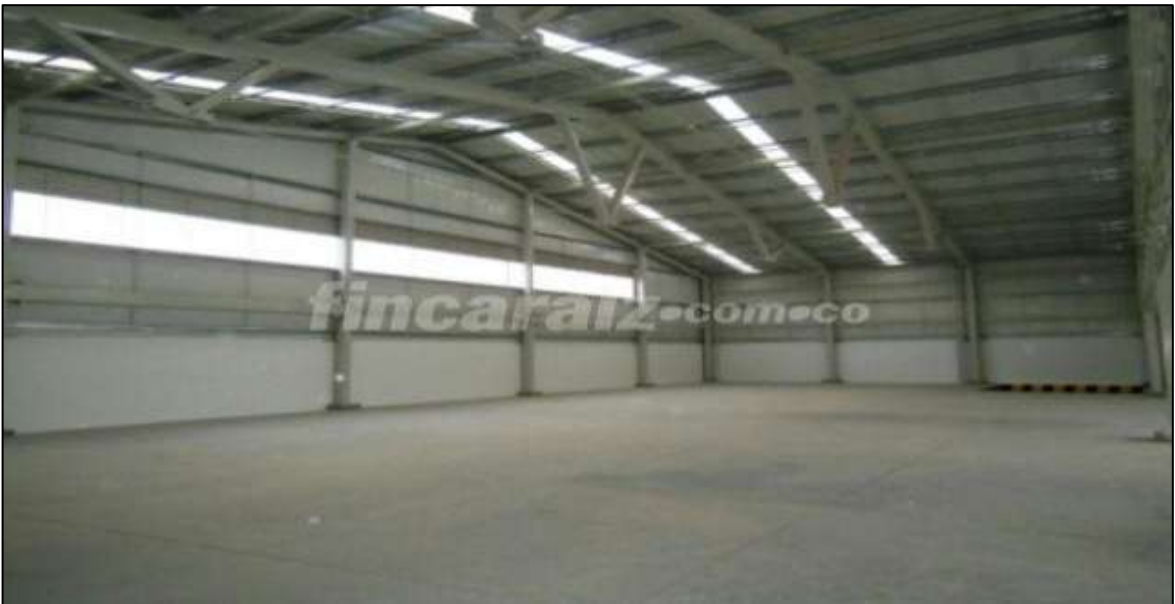
Figura 9. Interior de la empresa. Bodega con gran capacidad de maniobra para la manipulación y almacenamiento de los equipos
