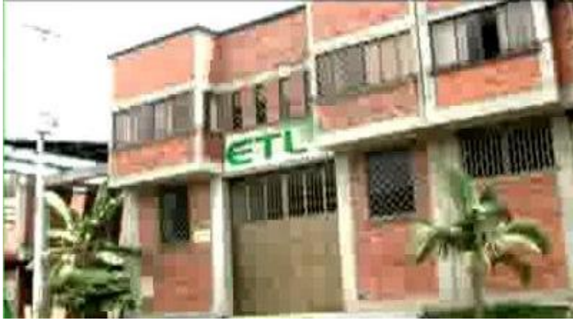
Figura 9. Actual bodega donde se encuentra Extrusiones Técnicas Ltda.
