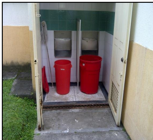
Foto 4. Depósito externo urgencias Fuente propia (Estudiantes) (AMAR/ MIP)
