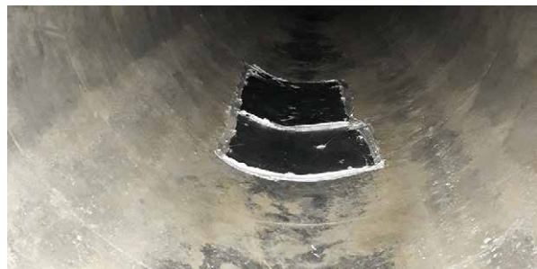
Kuva 4.2. Korjaushankkeen laadunvalvontatarpeen esimerkkejä: Siili ja hiekkaa erittäin likaisessa tuloilmakanavassa, poistettava ennen ilmanvaihtohormien puhdistusta (vasen yläkuva). Puhdistamatta jäänyt kanavanpäällinen (oikea yläkuva). Ruostunut tuloilmakanava ennen paikkausta (vasen alakuva) ja paikattuna, kun kanavan vaihto ei ollut mahdollista (oikea alakuva).
