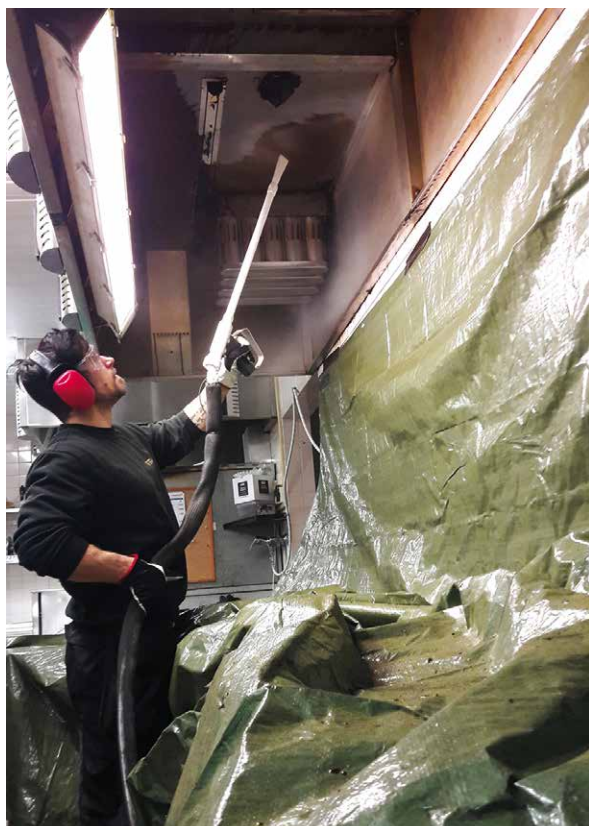
Kuva 3.6. Pinttyneen rasvahuuvan kuivajääpuhallus (vasen kuva). Öljylämmityksen kattilahuoneessa kattilan taakse savupiipun savukaasujen poistoputken asennettu kondenssiveden poistoletku (oikea kuva).
