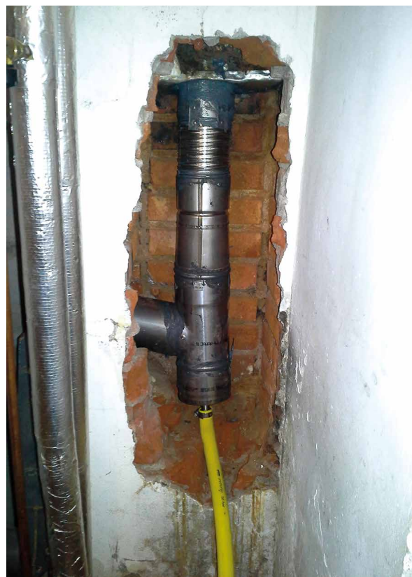
Kuva 3.6. Pinttyneen rasvahuuvan kuivajääpuhallus (vasen kuva). Öljylämmityksen kattilahuoneessa kattilan taakse savupiipun savukaasujen poistoputken asennettu kondenssiveden poistoletku (oikea kuva).
