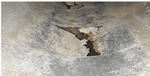
Kuva 4.2. Korjaushankkeen laadunvalvontatarpeen esimerkkejä: Siili ja hiekkaa erittäin likaisessa tuloilmakanavassa, poistettava ennen ilmanvaihtohormien puhdistusta (vasen yläkuva). Puhdistamatta jäänyt kanavanpäällinen (oikea yläkuva). Ruostunut tuloilmakanava ennen paikkausta (vasen alakuva) ja paikattuna, kun kanavan vaihto ei ollut mahdollista (oikea alakuva).
