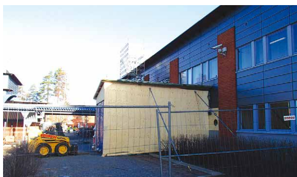
Kuva 3.13. Sulkuseinän laajentuminen tuulikaapiksi (vasen yläkuva). Sulkuseinällä suojattua alakattoa (oikea yläkuva). Lyhytaikainen alipaineistettu sulkuosastoseinä ulkoseinärakenteen korjauksessa, kun muu osa sisätilaa on normaalisti käytössä ja sulkuosaston kautta kulkeva ilma on johdettu suodatettuna ulos (vasen alakuva). Tuulikaappi/sulkuosasto (oikea alakuva). (Kuvat: Mikko Kallinen, Sirate Oy)
