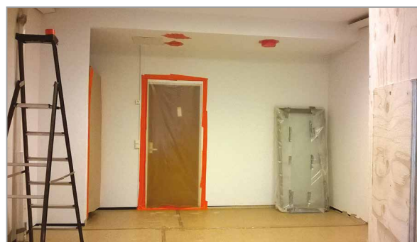
Kuva 3.12. Suojaukset ovat olennainen osa pölynhallintaa. Teippiä käytettäessä sen kiinnitys on varmistettava päivittäin. (Kuva: Esko Sistonen)
