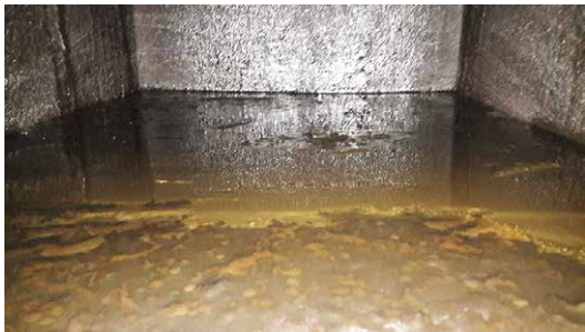
Kuva 5.5. Poistoilmahormin vedonparantaja voi parantaa sisäilman laatua (vasen yläkuva). Tukkeutunut lämmityspatteri on esimerkki huoltotoimenpiteiden laiminlyönnistä (oikea yläkuva). Keittiön poistoilmanvaihtokanavan pohjalta oleva rasva lisää paloturvallisuusriskiä (vasen alakuva). Puhdistettu lämmityspatteri (oikea alakuva).
