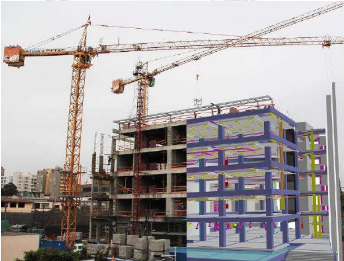
Figura 7 – Representación 3D mediante uso BIM - Fuente: Vladimir Alcántara Rojas, 2013
