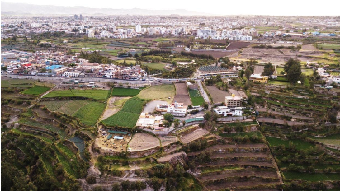
Imagen 5: Vista aérea-macro/ Carmen Alto dentro de Arequipa
