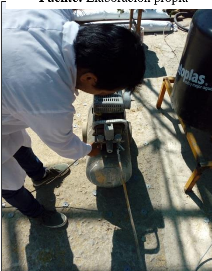
Figura 36. Verificando la presión de ingreso del aire hacia el tanque.
