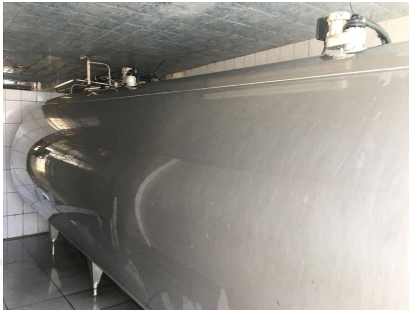
FIGURA 3: TANQUE DE ENFRIAMIENTO
