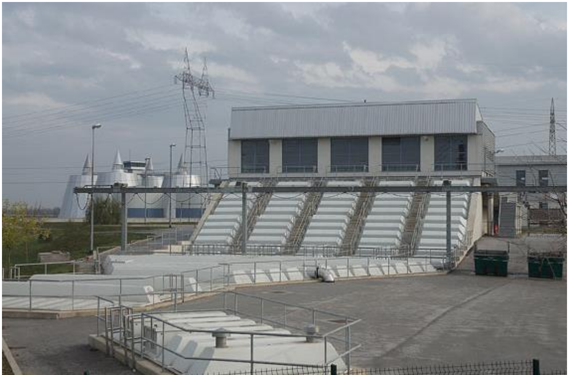
Slika 6-1. Ulazna crpna stanica s grubom rešetkom (ZOV 2009)
