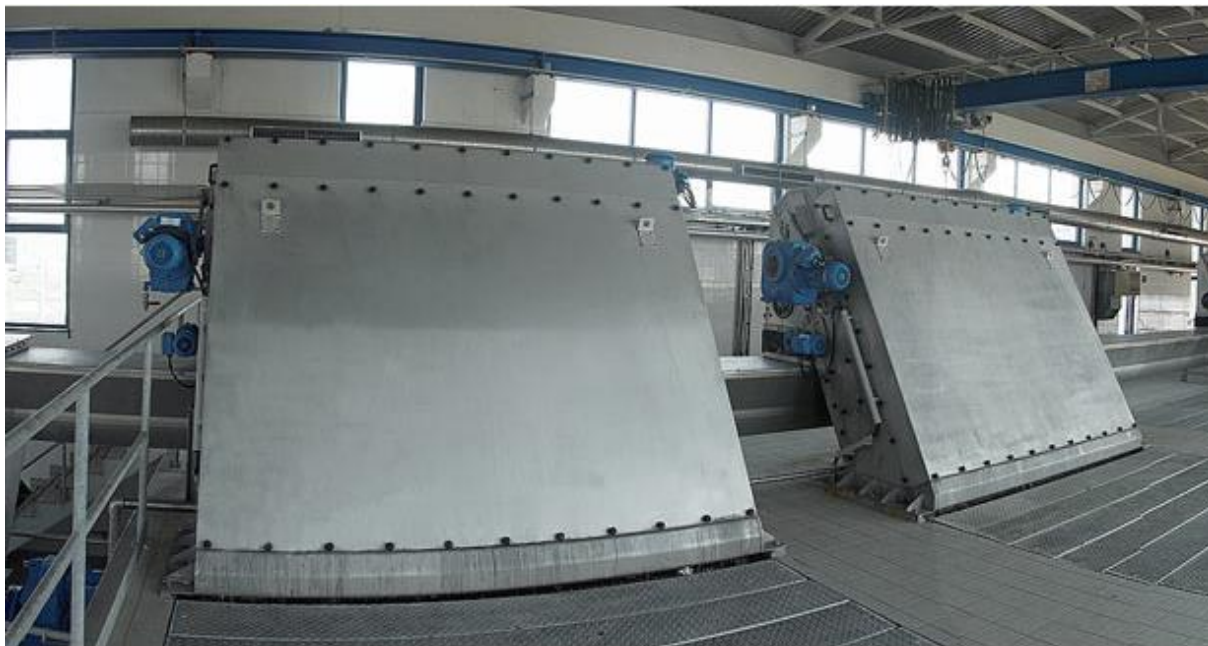
Slika 6-2. Zgrada s finim rešetkama (ZOV 2009)
