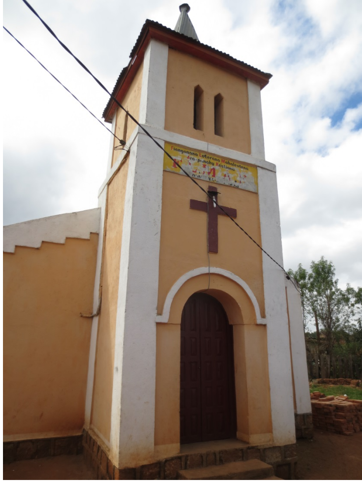
FLMAK – Ambohimena Antsirabe: Exterior
