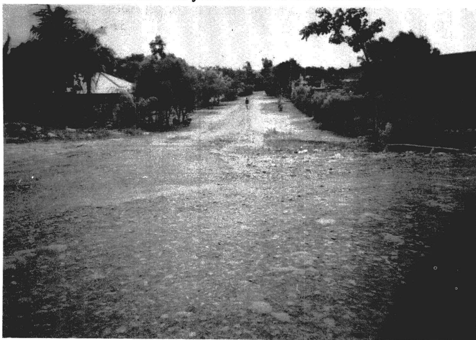
Gambar 2 Kondisi ruas jalan kerakal yang sudah diaspal
