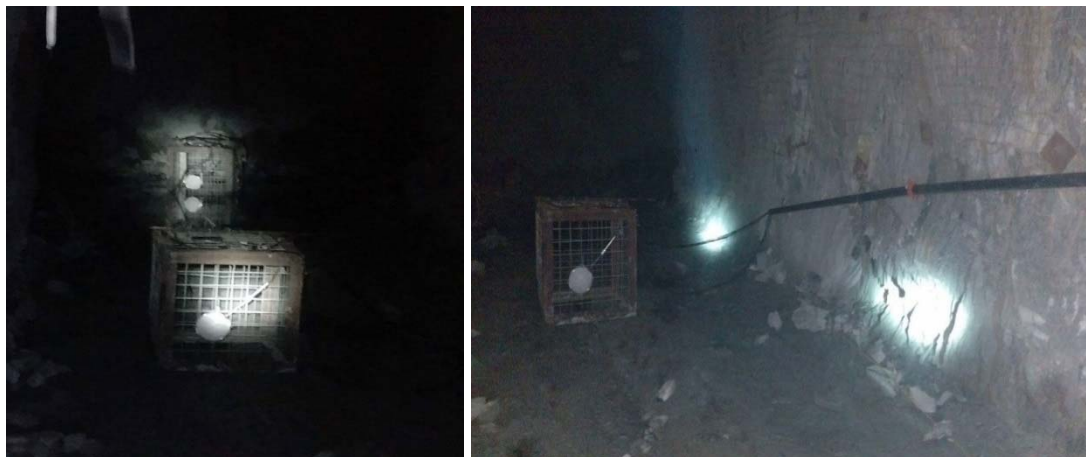
Figure 3–27 Cages instrumentées dans le chantier #83
